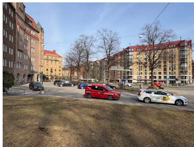
Nedan: Inom den runda Linnéplatsen står en rad med parklindar från 1960-talet. Trädraden följer fasadens rundning i kvarteret Malmgården (vänster).
