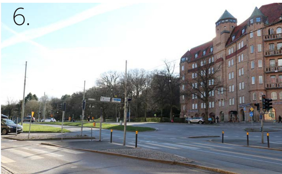
6. Vy från Linnégatans södra mynning vid Linnéplatsen mot söder och Slottsskogens entréparti. Till höger 1913 års bebyggelse i kvarteret Malmgården, vars svängda huskropp stärker läsbarheten av den riksintressanta Linnéplatsen som en länkande stjärnplats mellan stenstad och park. Naturhistoriska museet skymtar genom träden i bildens mitt.
